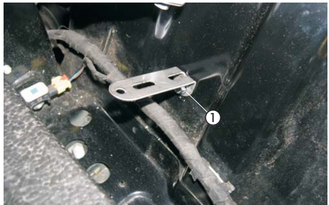
Abb. 21 ① Halter Abgasrohr montiert
