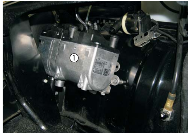
Abb. 19 ① Heizgerät montiert
