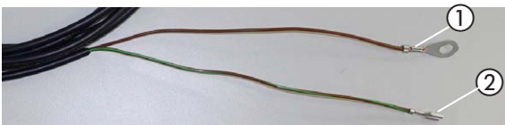
Mantelleitung mit Kabelschuh A6 und Steckhülse vorbereitet
