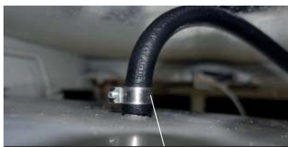
Entlüftungsschlauch \varnothing 10 mm angeschlossen
